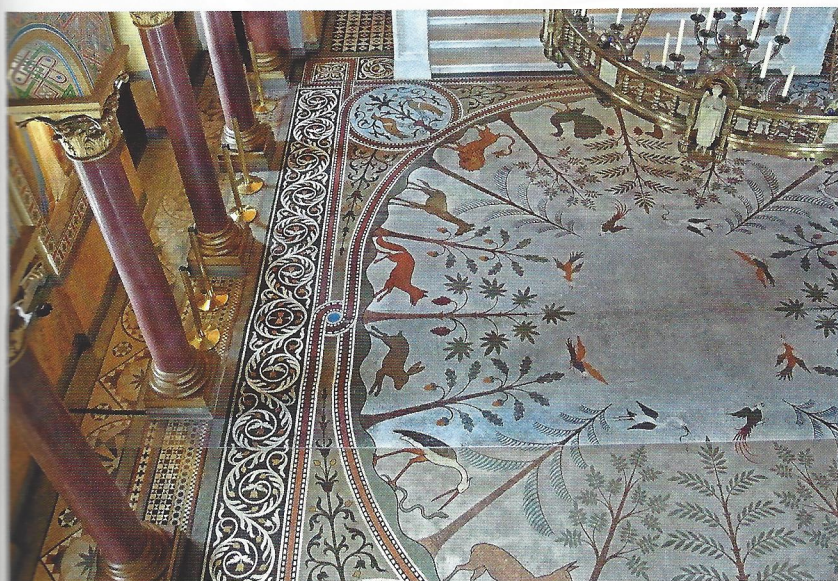
Das wertvolle Mosaikmuster erhielt als Schutzschicht einen PVC-„Fotoboden“. Ein Unterschied zum Original ist kaum erkennbar. (Aufnahme mit freundlicher Genehmigung der Bayerischen Schlösserverwaltung)
